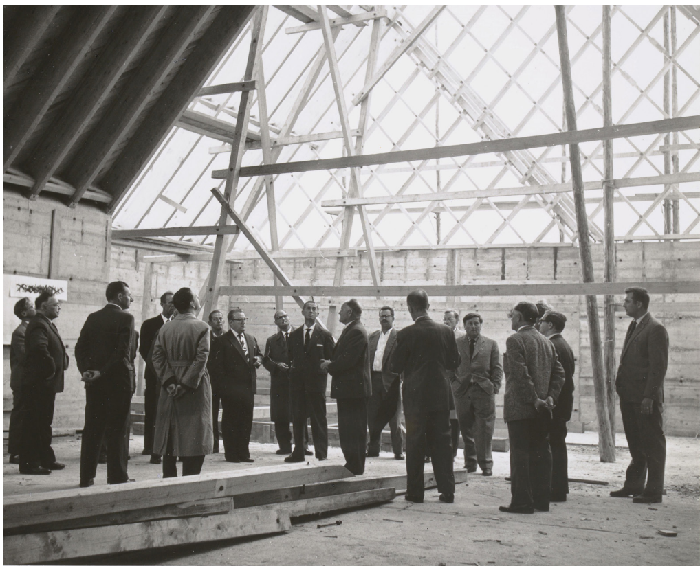
Foto: Baustellenbesichtigung, Reformierte Kirche Effretikon, 1960. gta Archiv / ETH Zürich (Vorlass Ernst Gisel)
